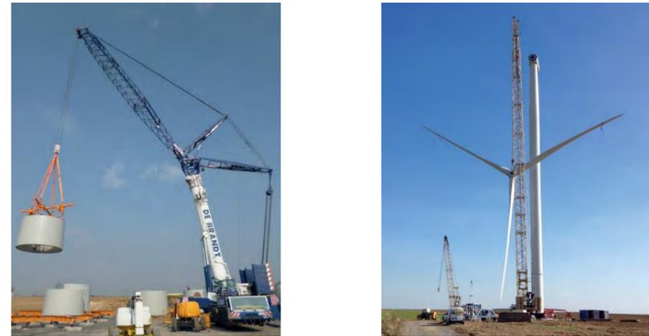
Figure 118 : Exemple de montage du mât et levage d'un rotor (source : wpd, 2018)
