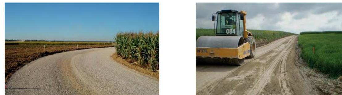
Figure 115 : Aménagement des chemins d'accès d'un parc éolien (source : wpd, 2018)
