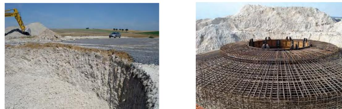
Figure 116 : Aménagement des fondations d'un parc éolien (source : wpd, 2018)
