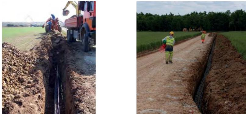
Figure 117 : Travaux de raccordement électrique d'un parc éolien (source : wpd, 2018)
