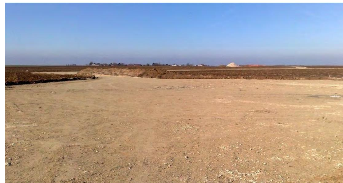
Figure 114 : Exemple d'aire de montage, grave compactée sur géotextile
